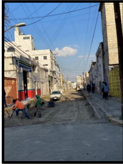
Imagen No. 6 Rehabilitación y reencarpetamiento en la calle Instituto Literario, Toluca de Lerdo
